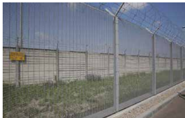
Palo Omega con piatto 60x40x25x3 o 120x60x30x3 mm
